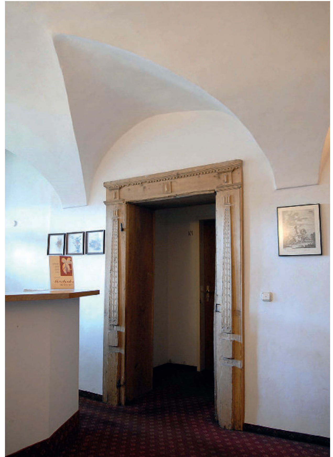
Tür zum früheren Tanzsaal der Klosterherberge im Obergeschoss
